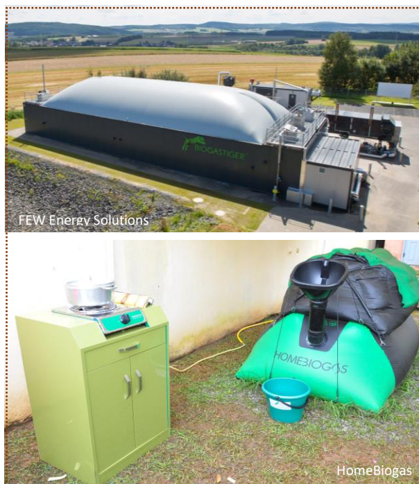
Exemples de méthaniseurs En haut : unité de méthanisation de taille moyenne, en bas : méthaniseur domestique de petite dimension
