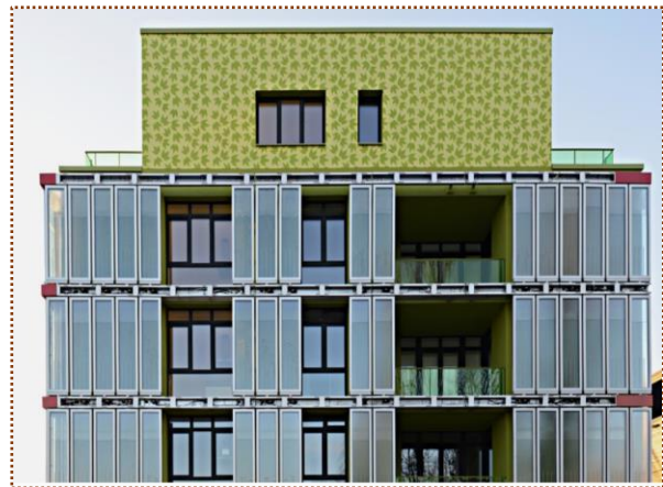
« Bio Intelligent Quotient House » à Hambourg, en Allemagne, avec sa façade « SolarLeaf » de bioréacteurs en panneaux de verre plats contenant des microalgues, qui produisent de la bioénergie et du chauffage pour l'édifice.
